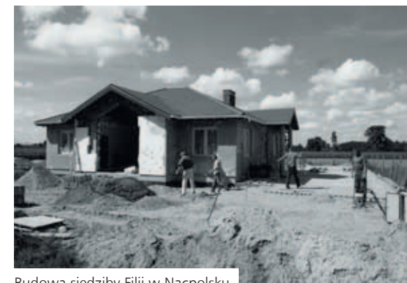
Budowa siedziby Filii w Nacpolsku Oddziału w Naruszewie
