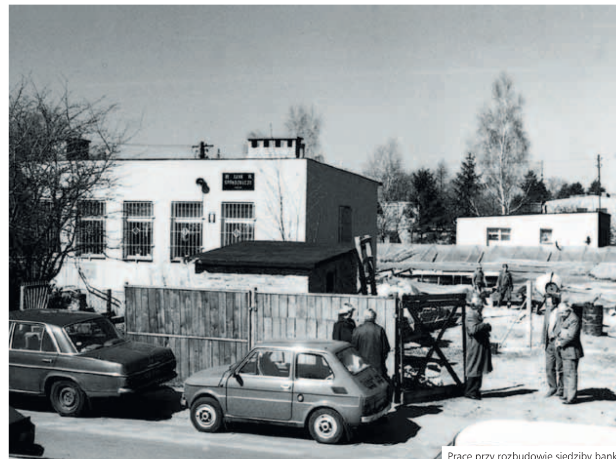
Prace przy rozbudowie siedziby banku
